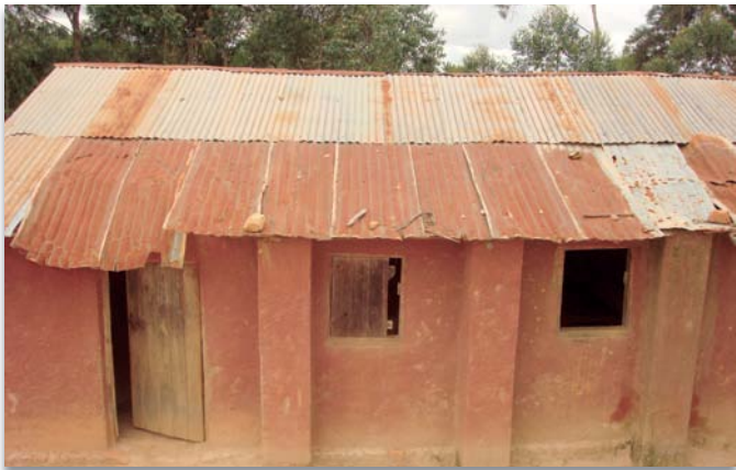
Schule in Kituli /Kenia vor der Renovierung 2012
