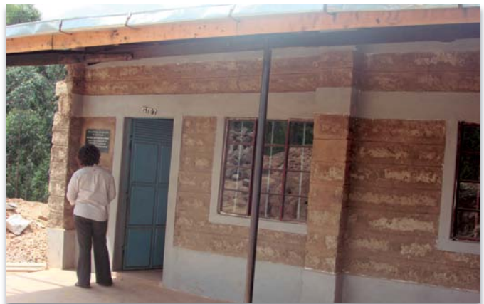
Schule in Kituli /Kenia nach der Renovierung 2014
